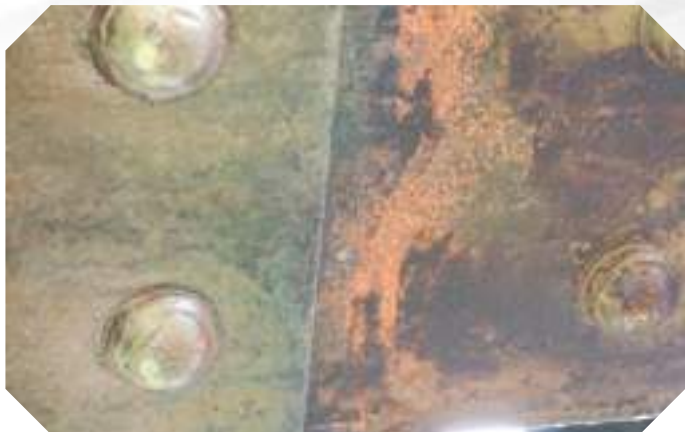
Чистка конструкций из металла
