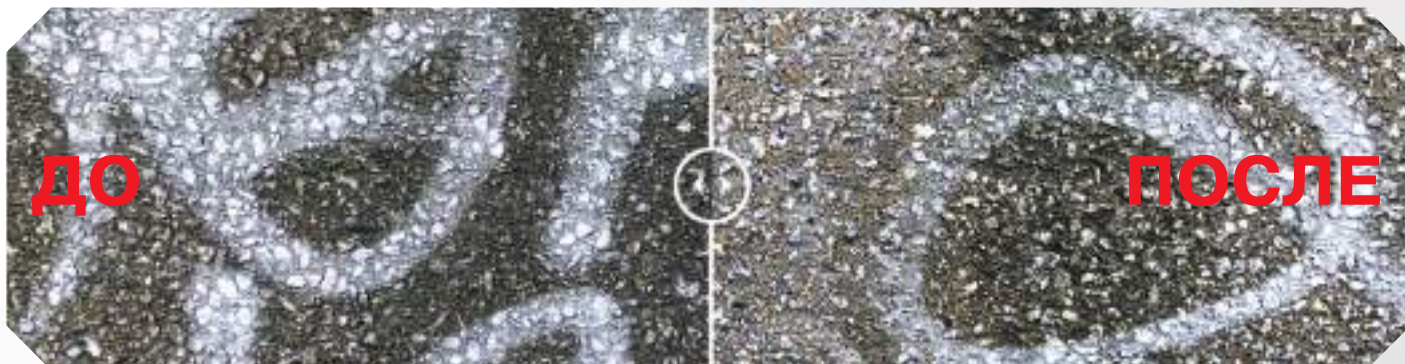
Чистка бетонных поверхностей от граффити
