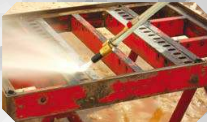
Чистка поверхностей от старой краски
