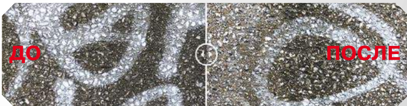
Чистка бетонных поверхностей от граффити
