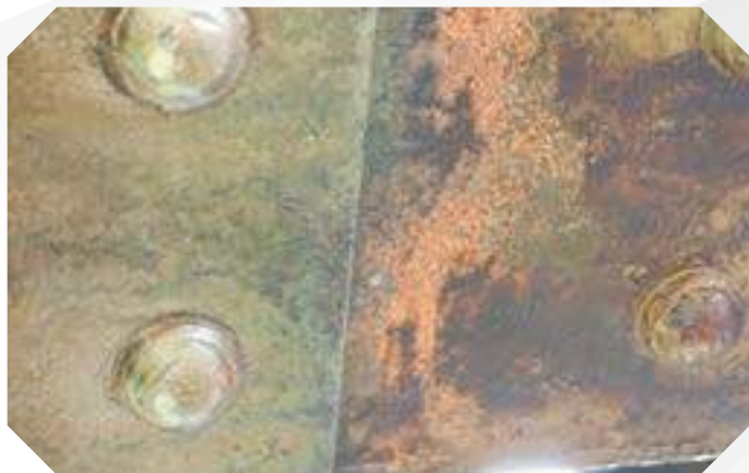
Чистка конструкций из металла
