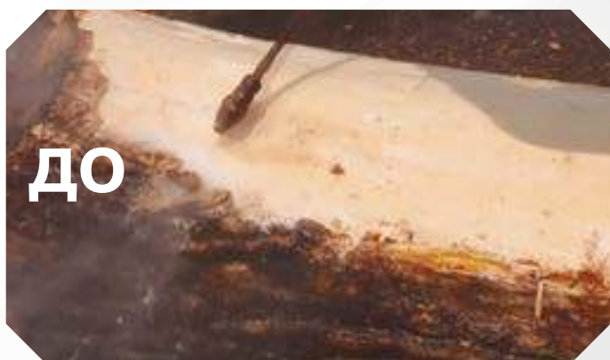
Окорка брёвен (удаление коры)
